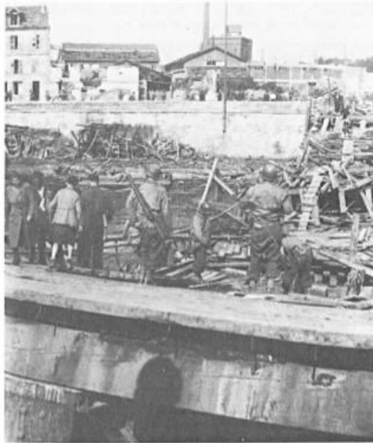
Le plan d'eau a été abaissé. Une passerelle a été aménagée sur les débris du pont.
